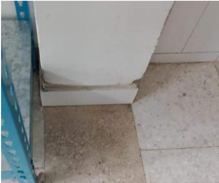
IMAGEN 3. Arreglo baldosa fuera de eje.
