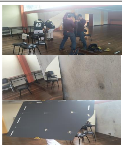
Desde el empalme se recibió el espejo del salón de danza del segundo piso de Casa de Cultura (dotado por el MinCultura) roto Una estudiante de la Escuela infantil Iniciación de ballet se recargo sin culpa y término de sellarlo Se gestiono para que empresa retirara el espejo y así evitar accidentes en cada una de las clases que se dictan
