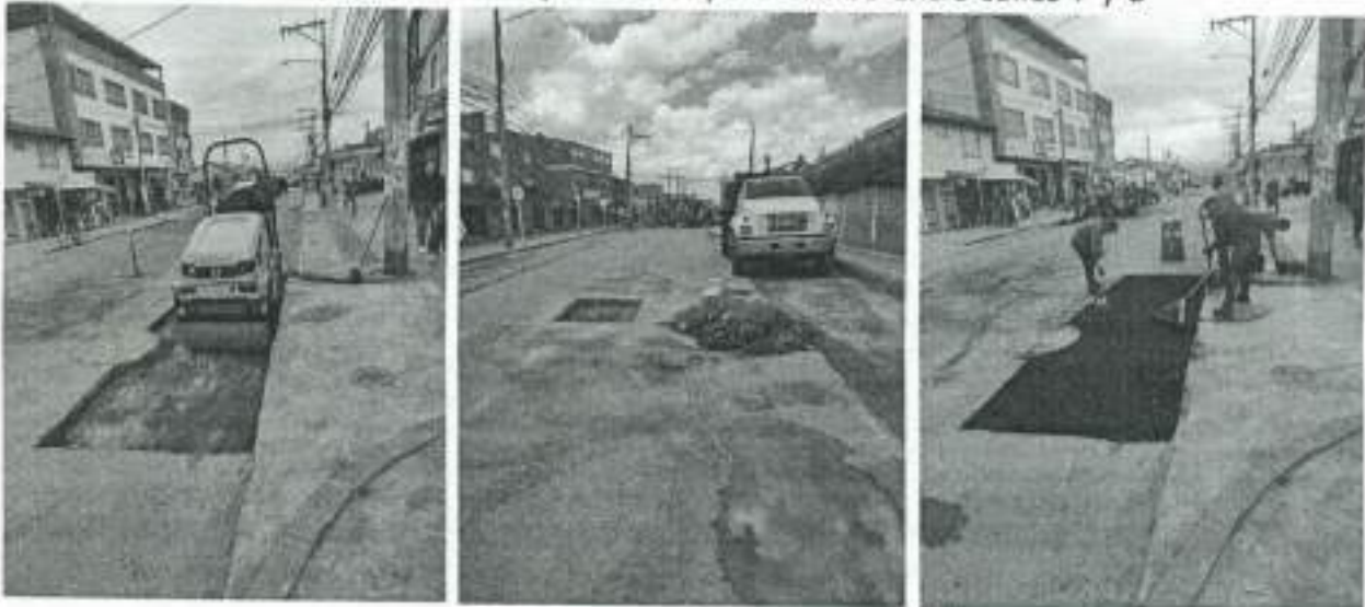
Equipo, Material y Personal para Cra 10 entre calles 7 y 3
