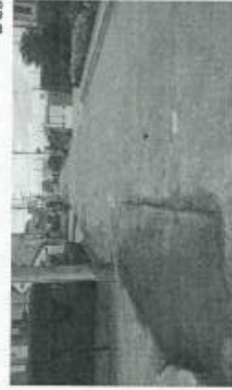
7.2 Mantenimiento preventivo y correctivo mediante reparcheo con MDC-19 en la carrera 5 este * calle 7
