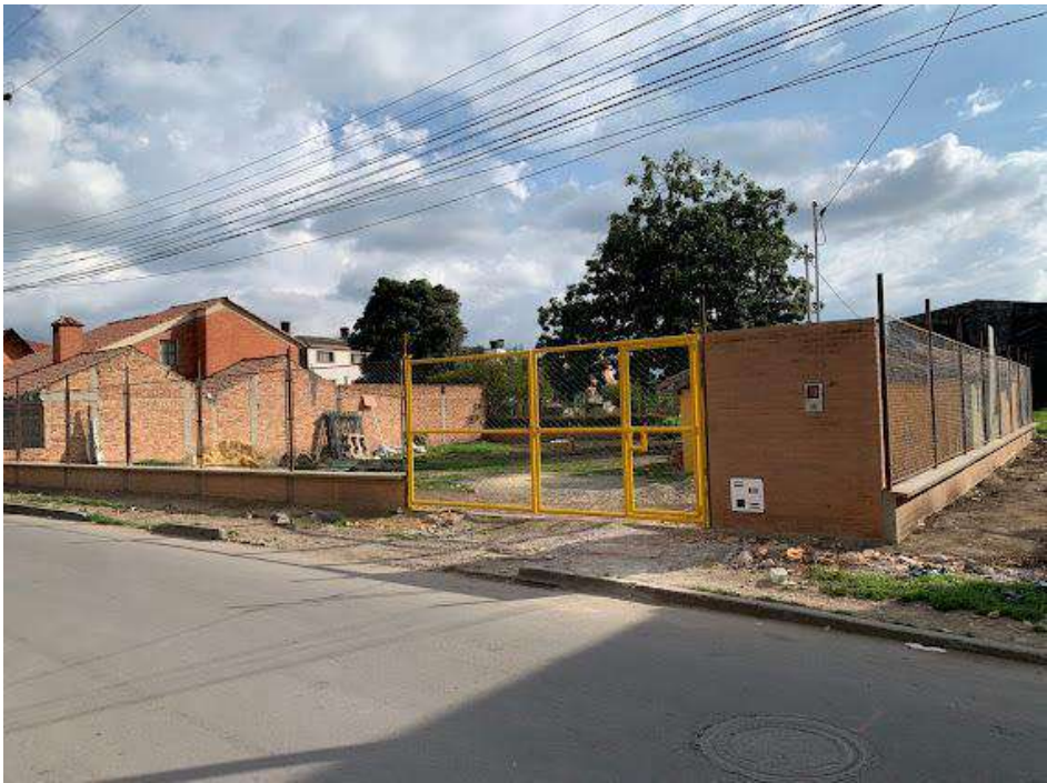
Acompañamiento verificación cierre de predios IDUVI
