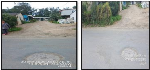
IMÁGENES 1 Se aprecia intervención realizada en asfalto, reparada y en condiciones visiblemente aceptables, fecha de verificación 30 de enero de 2025.
