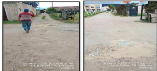
IMÁGENES 1 Se aprecia intervención realizada en asfalto, reparada y en condiciones visiblemente aceptables, fecha de verificación 30 de enero de 2025.
