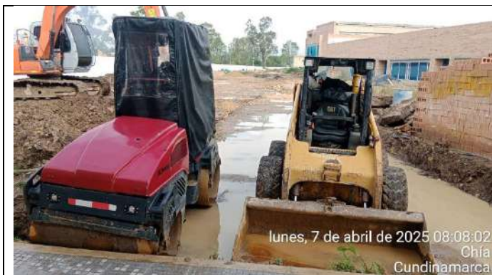
Estado del ingreso a obra, posterior al bloque 1 portería
