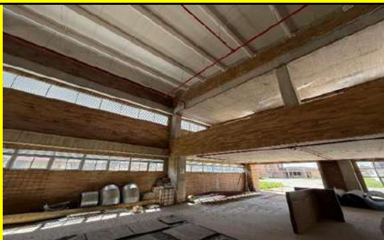
Interior del bloque 1, aula múltiple y cocina, servicios, tienda
