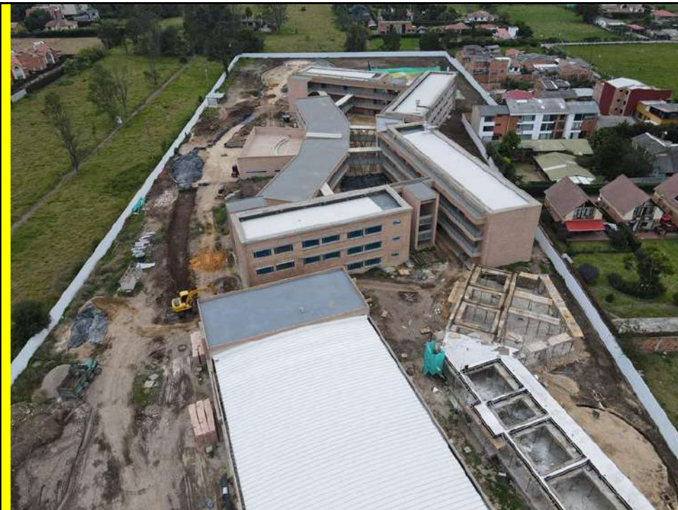
Visual aerea de bloque 2 aula múltiple y administración, bloque 4 en construcción y bloques 3
