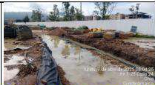
Visual de la zona de parqueaderos en estado de mejoramiento
