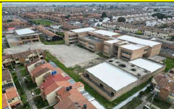
Visual general de los bloques construidos a la fecha, bloques 1 aula múltiple, 3 aulas y 4 preescolar
