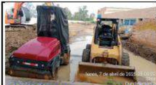
Estado del ingreso a obra, posterior al bloque 1 porteria
