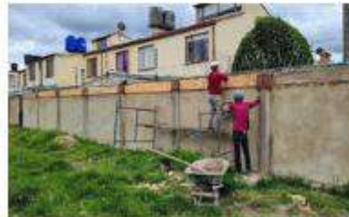
Fotografía No.3 Fundida de vigas de anclaje de los muros de cerramiento
