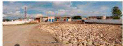
Visual bloque 1, portería, SHUT de basuras y control de ingreso a la IE Balaguer
