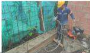
Fotografía No.3 Fundida de viga de cimentación para cerramiento
