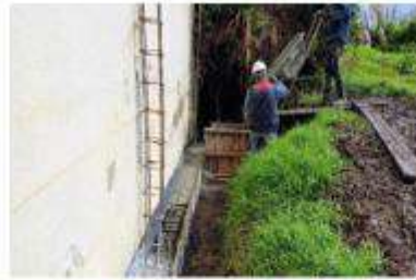
Fotografía No.1 Fundida de vigas y dados del tramo de cerramiento frente al conjunto los pinos
