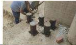
Fotografía No.4 Toma de muestras de concreto de viga de cerramiento
