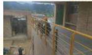
Fotografía No.6 Instalación de barandas y pasamanos
