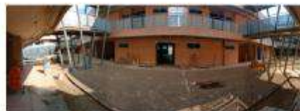
Visual interna entre bloques 3, frente bloque 3A biblioteca, laboratorios y aula polivalente
