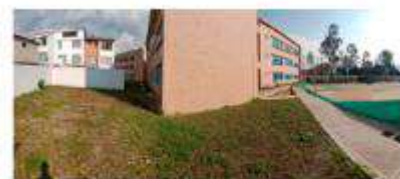
Visual zona norte posterior a bloques 3C y 3D, aulas especializadas
