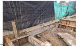
Fotografía No.2 Figurado e instalación de acero y fundida de viga concreto de cerramiento
