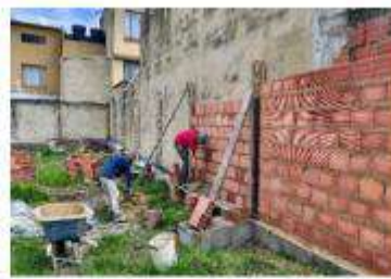
Fotografía No.2 avance con la mampostería del cerramiento
