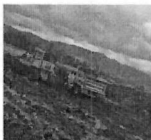
Estado botadero (volquetas enterradas)
