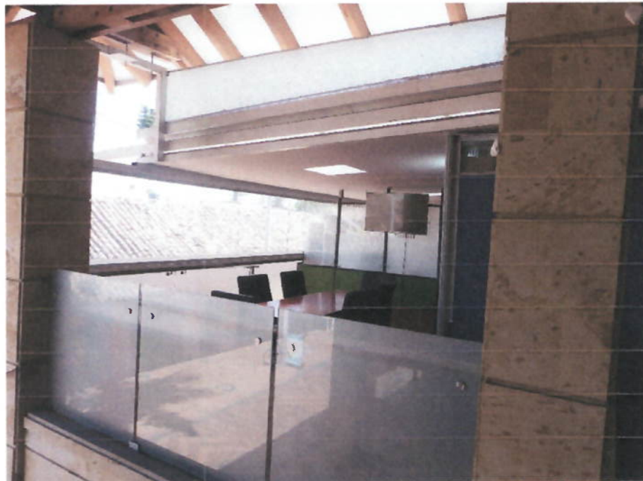
Detalle terraza -oficina- 2 piso
