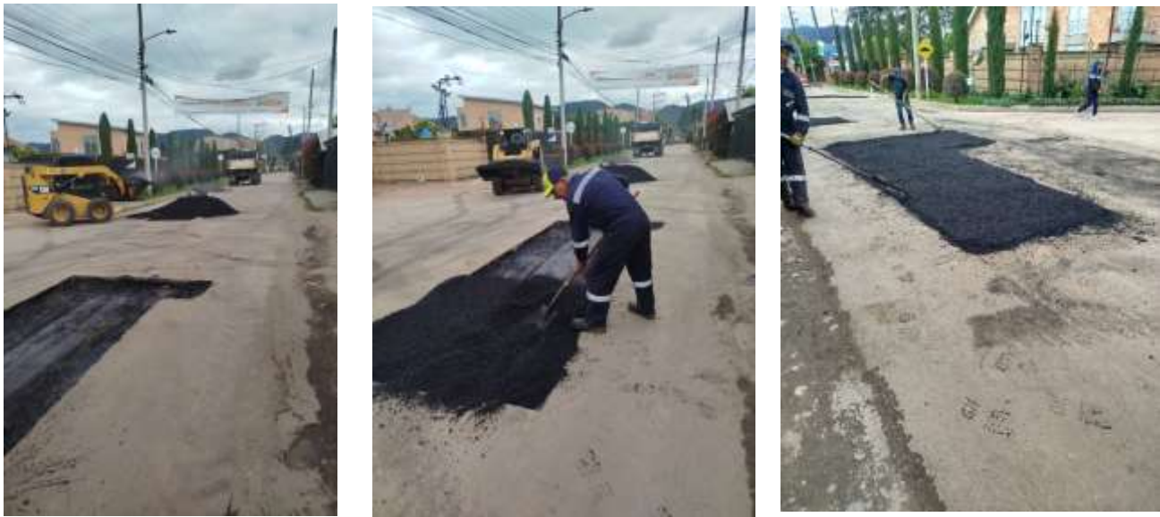
- Apoyo en mantenimiento con mezcla densa en caliente MDC-19 de las Vías en Vereda La Balsa
