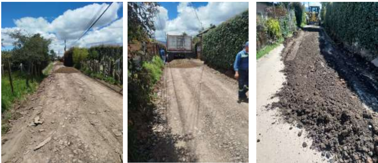
- Apoyo en mantenimiento de la vía Rincón de Fagua entre sectores Chiquilinda y el Chamizo
