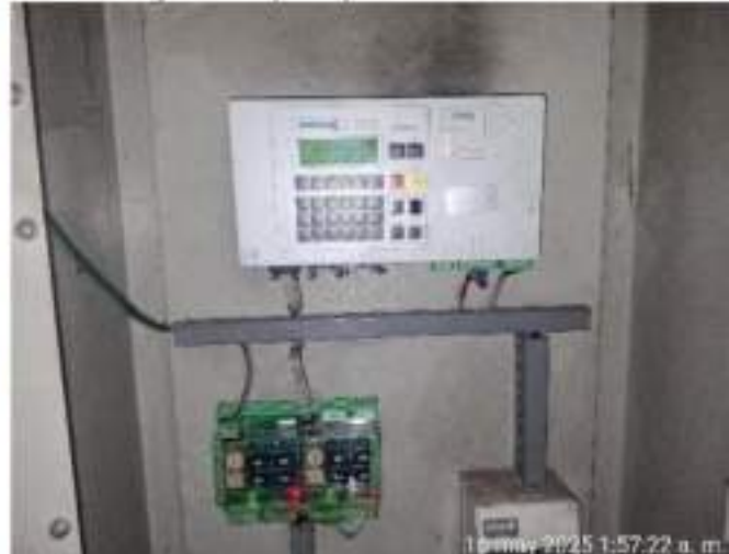
Ilustración 4. Registro fotográfico cambio tarjeta CPU principal.
