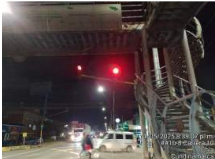
Intersección de la Calle 2 X Carrera 10
