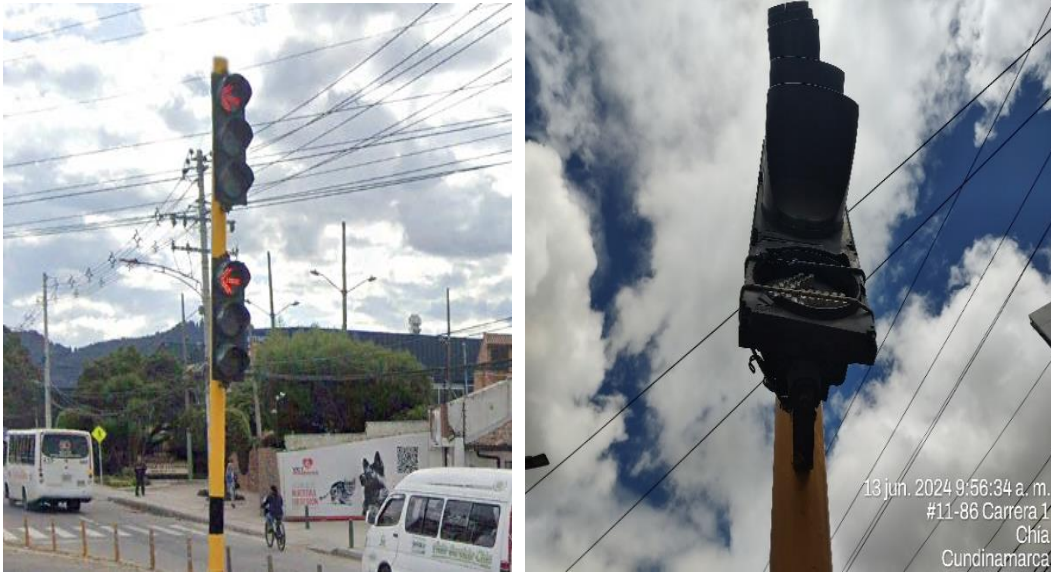
Ilustración 4. Módulo semafórico tipo S1. Pictograma flecha giro izquierdo.
