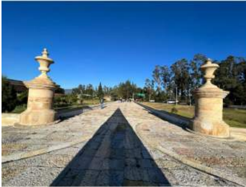
Figura 03 Puente del común
